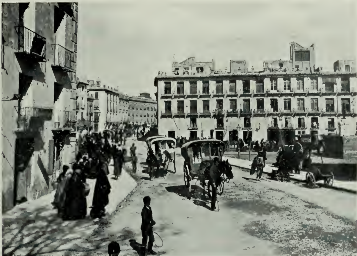
CALLE DEL PUENTE, MURCIA
